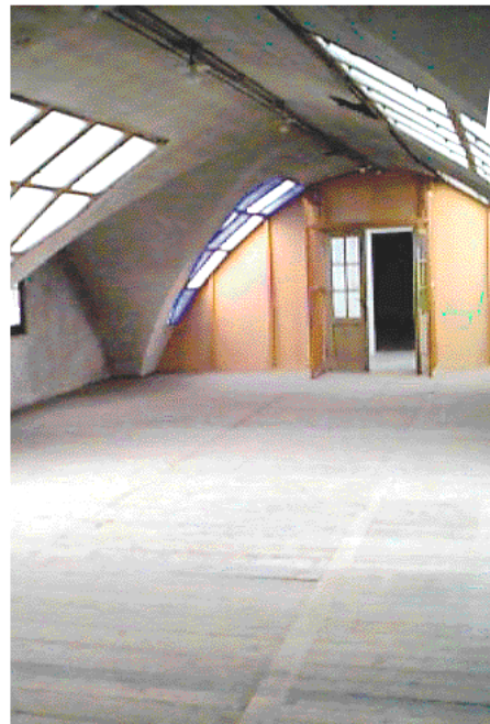
Die Räume vor der Renovation
